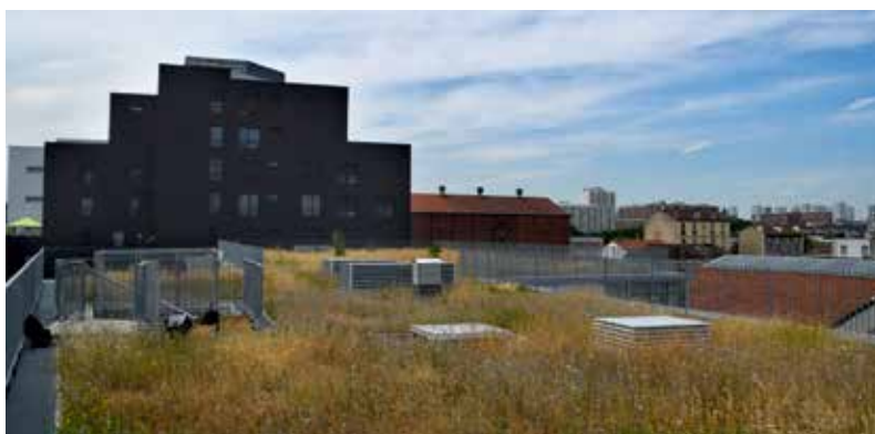
La toiture prairiale du centre scolaire Rosalind-Franklin à Ivry-sur-Seine accueille par exemple des nids de bourdons, des criquets et une flore variée. © Maxime Zucca | ARB îdF
